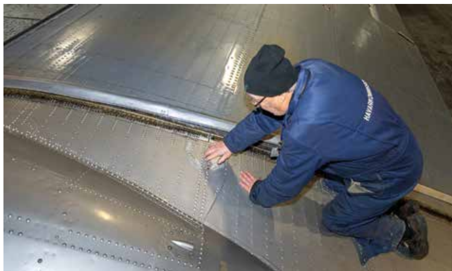
Høre vinge... udvendig korrosion kortlægges
